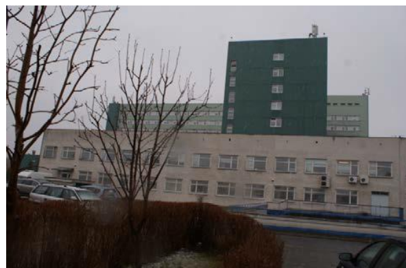
Blok 1C, 1B, 1A (elewacja E)
