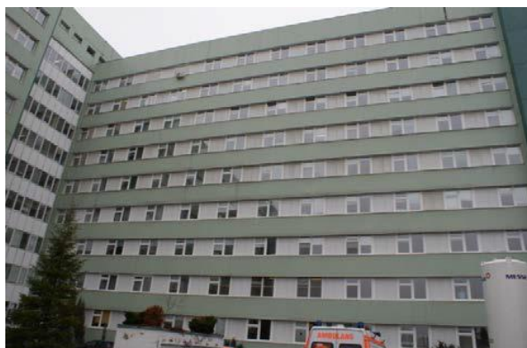
Blok 1B (elewacja S)
