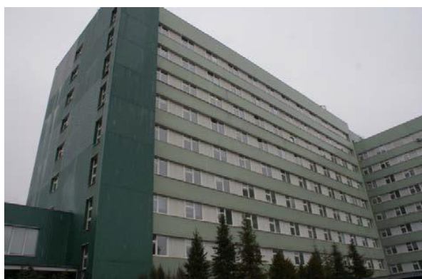
Blok 1C (elewacja W i S)
