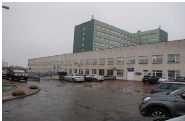
Blok 1B i 1A (elewacja E i N)
